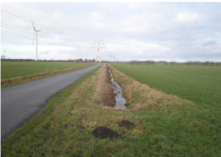
Foto 3: Straßenrandgraben ca. 100 m westlich
