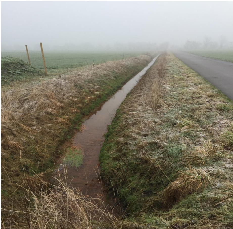
Bild 2: Einleitstelle; Verbandsgewässer: 24; Blickrichtung: Ost
