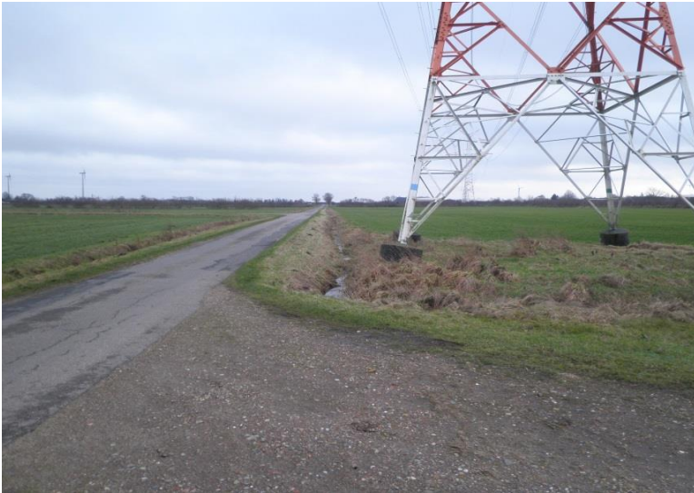
Foto 1: Standort - vorhandener Mast mit Straßenrandgraben
