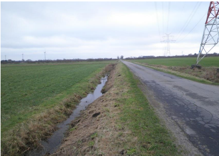
Foto 2: Straßenrandgraben ca. 20 m östlich
