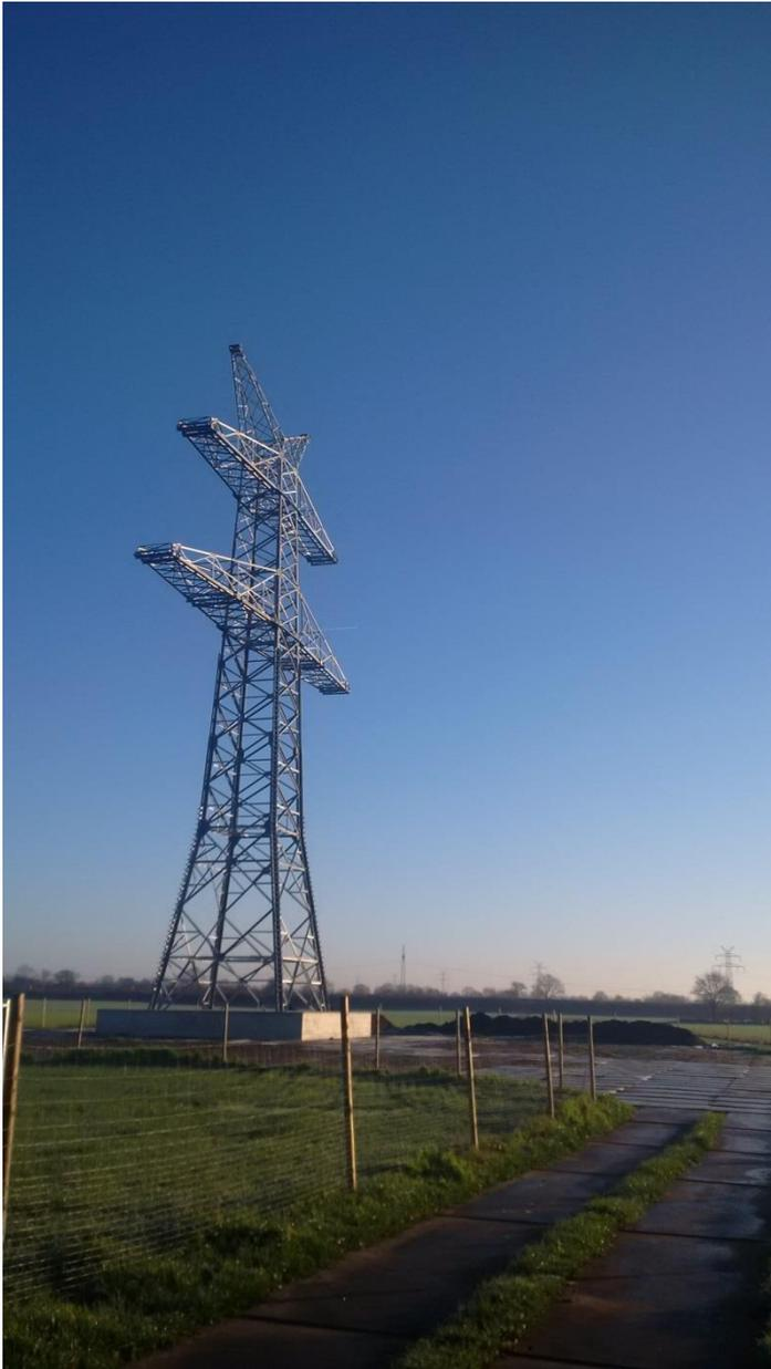
Abbildung 22e: 380-kV-Freileitungsprovisorium für zwei Systeme (Auflastvariante Stahlgittermast)
