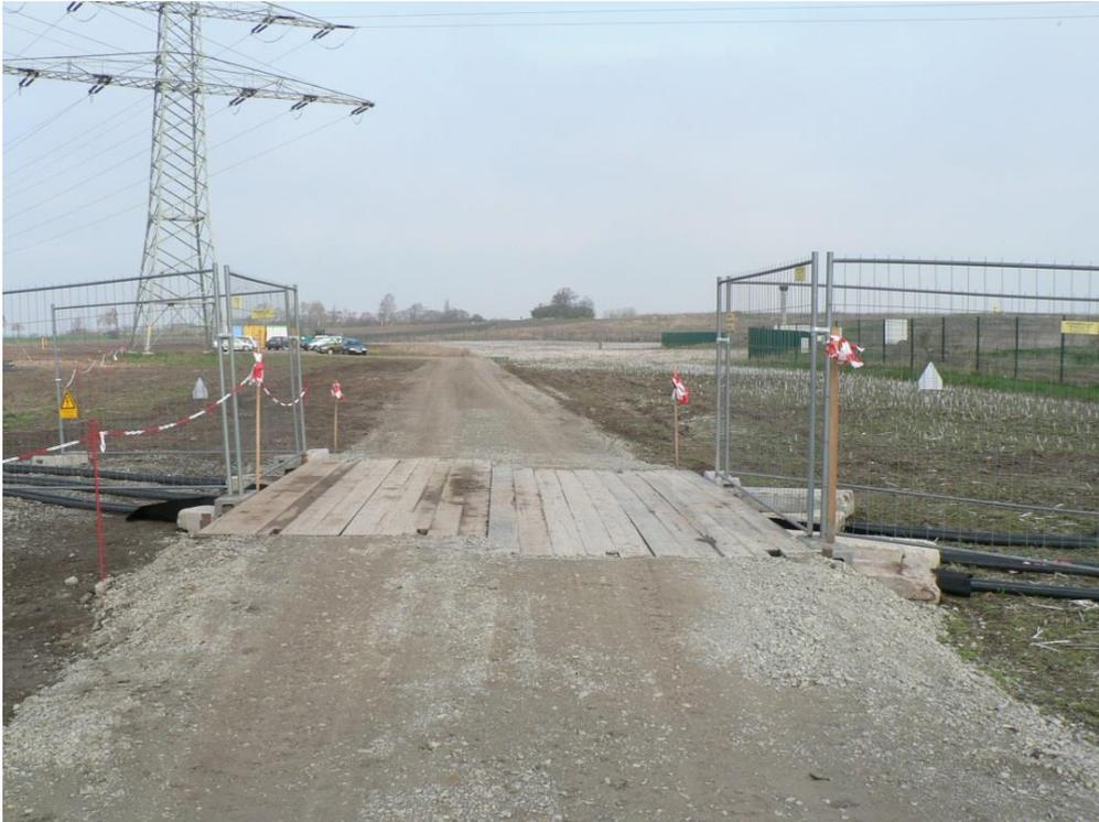
Abbildung 24: Beispiel eines Kabelprovisoriums über einen Weg
