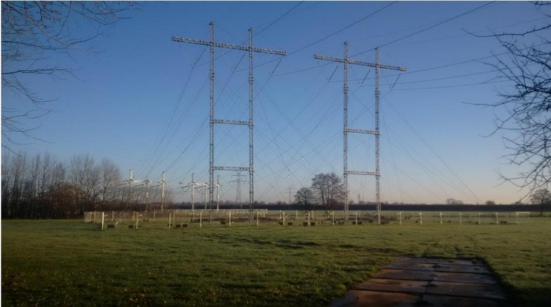
Abbildung 19b: 380-kV-Freileitungsprovisorium für zwei Systeme (mit Abankerung)
