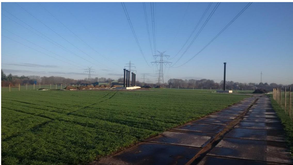
Abbildung 21d: 380-kV-Freileitungsprovisorium (Stahlvollwand) für zwei Systeme (mit Auflast, ohne Traversen; Abspannung jeweils am Stahlvollwandprofil)
