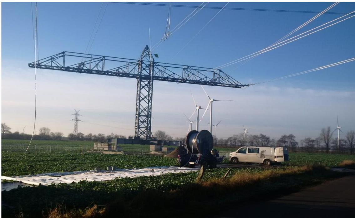
Abbildung 20c: 380-kV-Freileitungsprovisorium (Gitterstahl) für zwei Systeme (mit Auflast)
