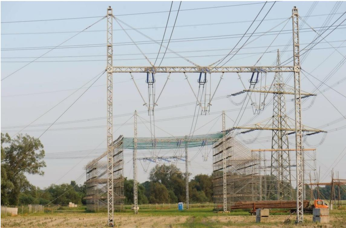
Abbildung 18a: 380-kV-Freileitungsprovisorium für ein System, mit errichtetem Schutzgerüst (mit Abankerung)
