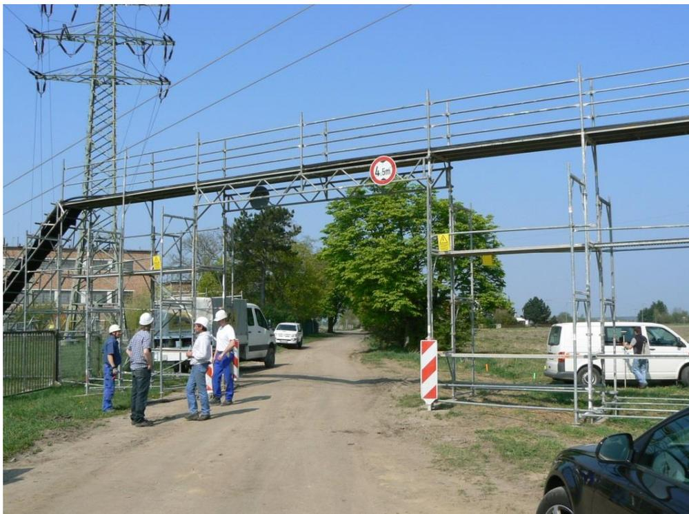
Abbildung 23: Beispiel einer Kabelbrücke über einen Weg
