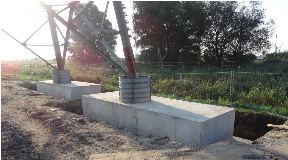
Abbildung 1: Fundament unter einem 380-kV-Mast
