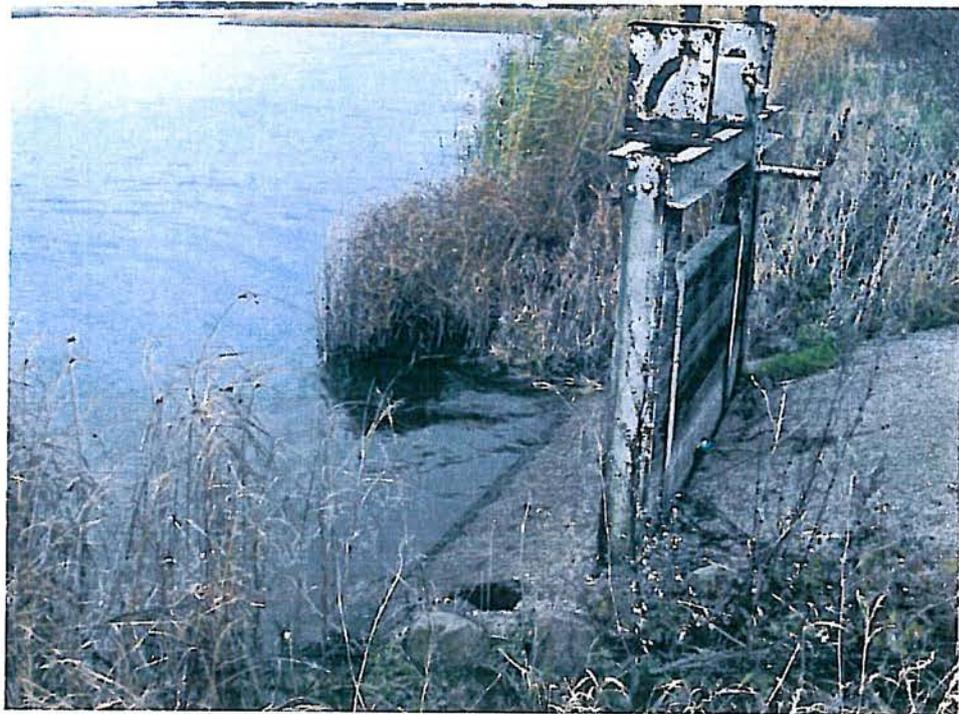
Abb. 12 Hubschützanlage am Auslaufbauwerk
