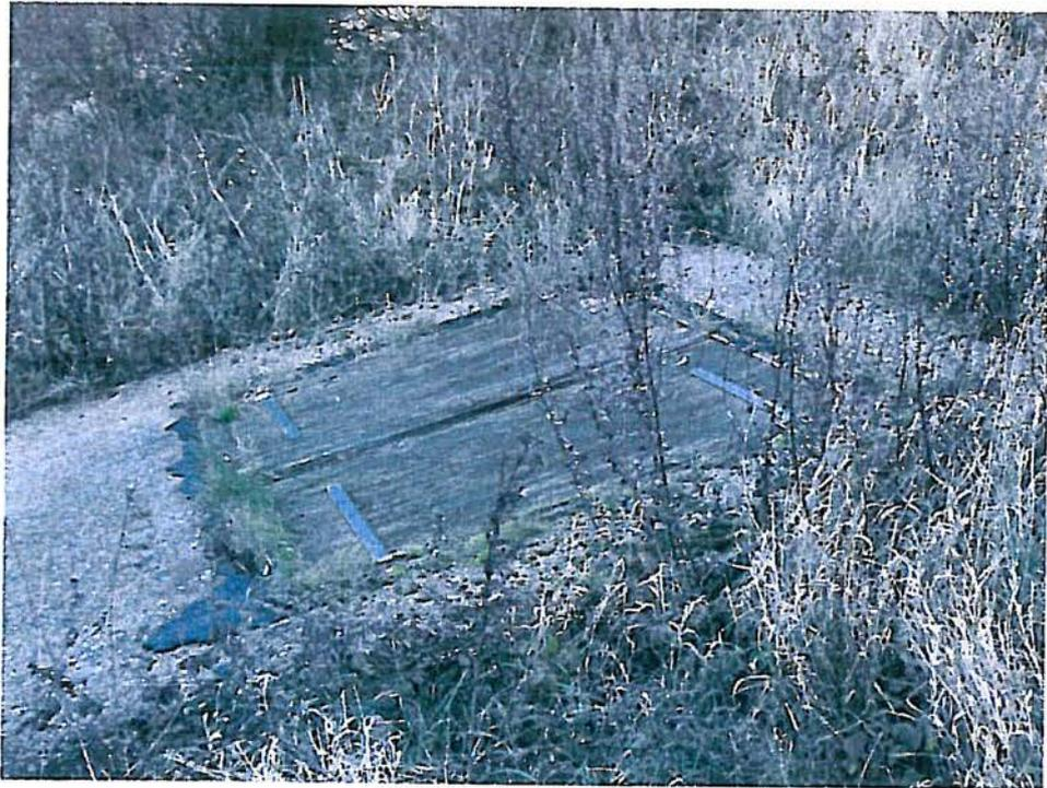
Abb. 13 Abdeckung des Einstiegs in das Auslaufbauwerk
