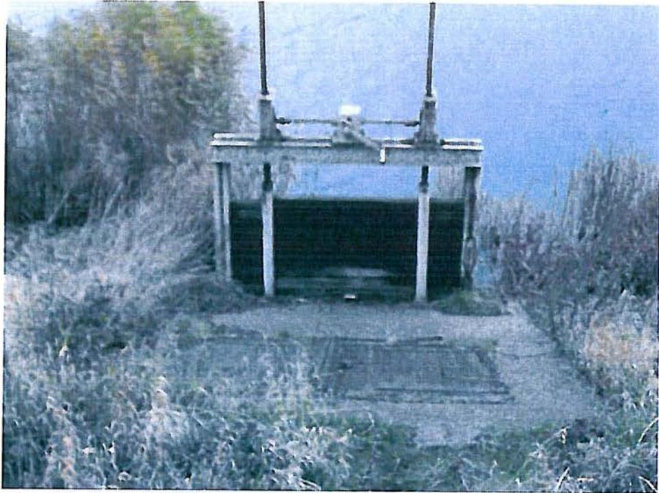
Abb. 11 Hubschützanlage am Auslaufbauwerk
