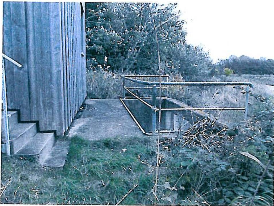
Abb. 6 Schöpfwerkseinlauf mit Bedienungspodest
