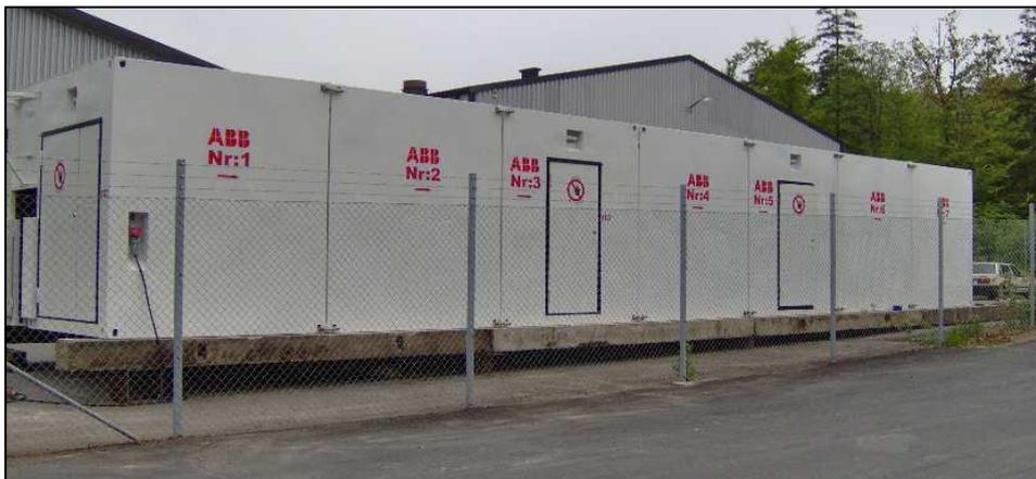
Abbildung 2: Muffencontainer zur Herstellung des Kabelverbindungssystems
