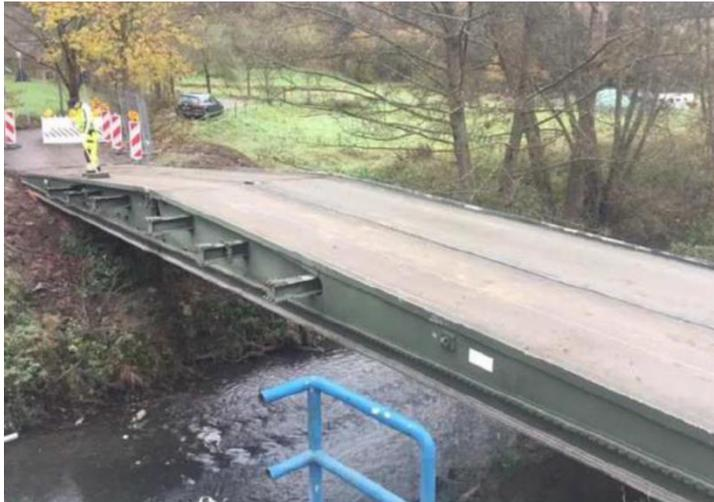
Abbildung 7: Beispiel für die Querung eines Vorfluters mittels mobiler Brückenkonstruktion
