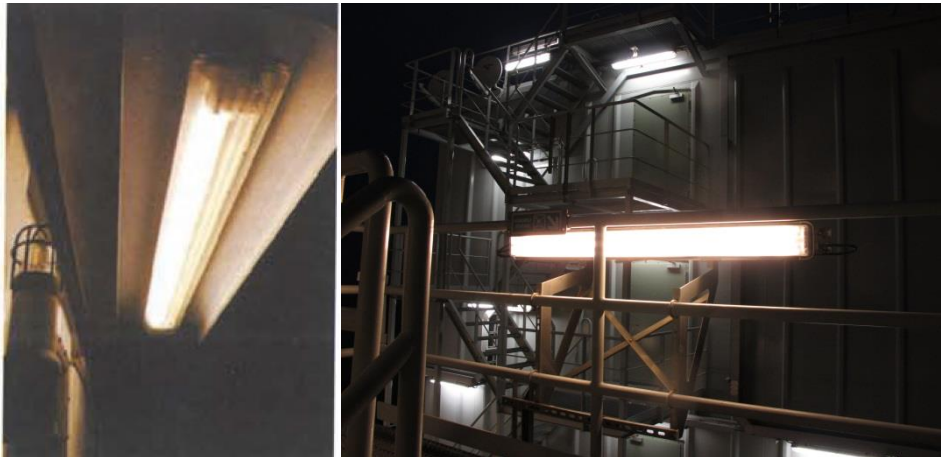
Abbildung 6: Leuchte mit Abschirmungsschild und halbierter Lichtstärke auf der Mittelplate (links) und Negativ-Beispiel für Leuchte ohne Abschirmung und unangepasster Lichtstärke.
