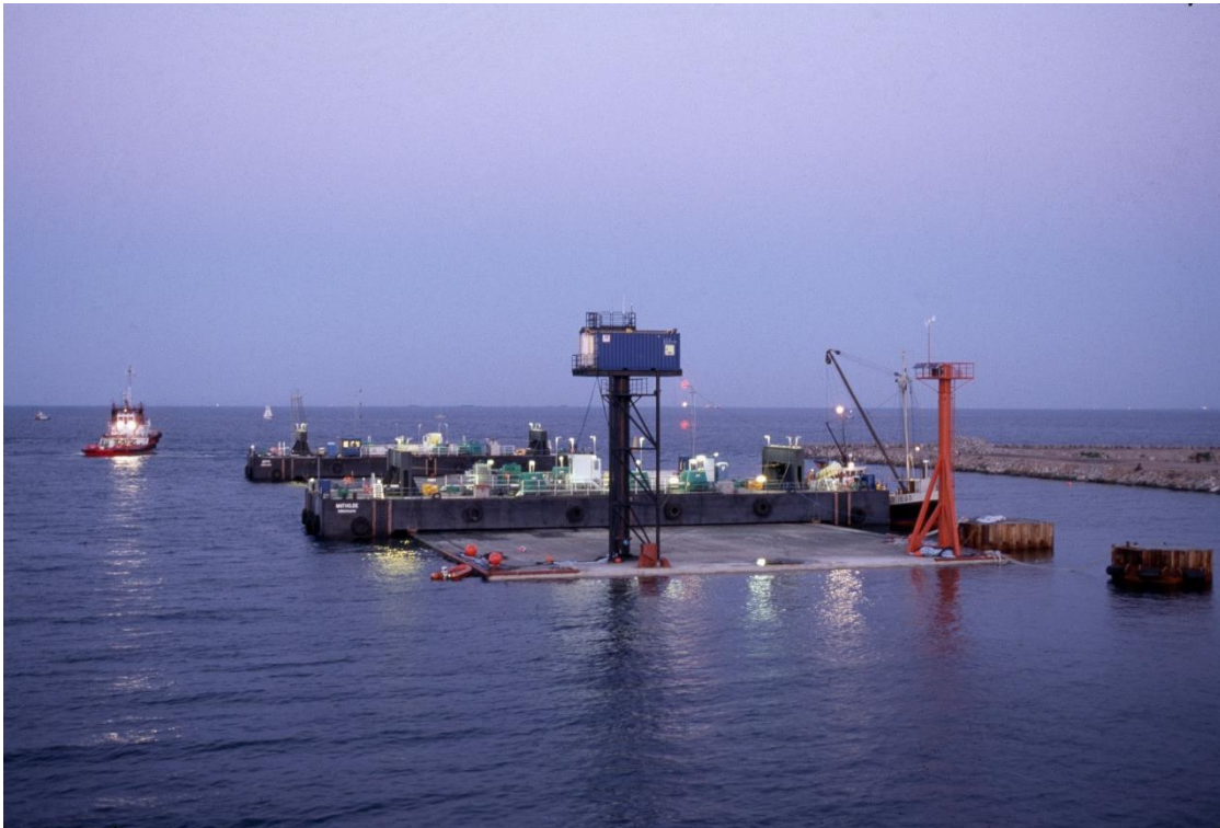
Abbildung 2: Beispiel einer Beleuchtung einer Baustelle im marinen Bereich (Foto: Femern A/S); hier ist noch kein Lichtminderungskonzept aktiv.
