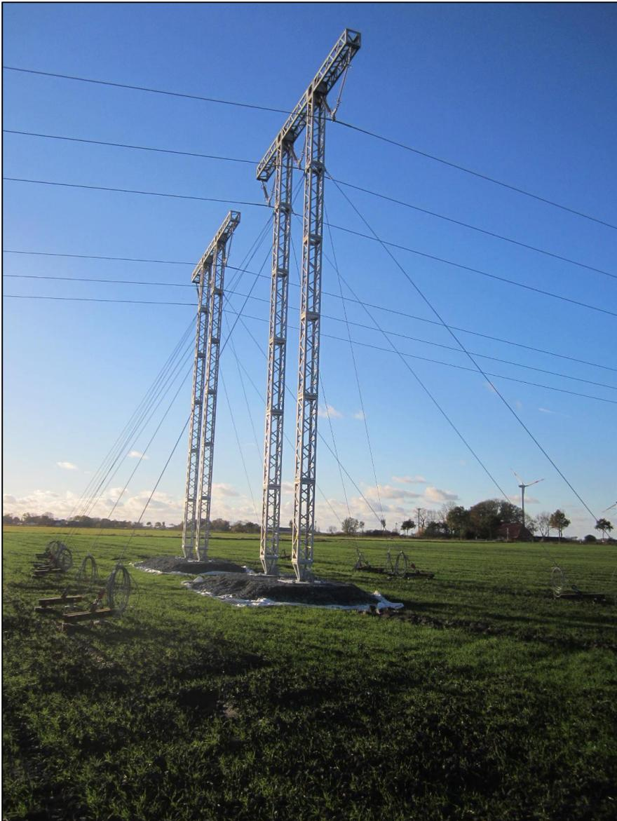
**Abb. 6: Beispiel zweisystemiges Freileitungsprovisorium (SH Netz 2017)**
