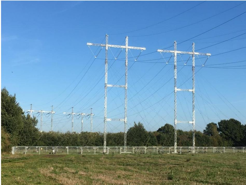
Abbildung 4 110-kV-Freileitungsprovisorium als Träger für zwei Systeme (mit Abankerung)
