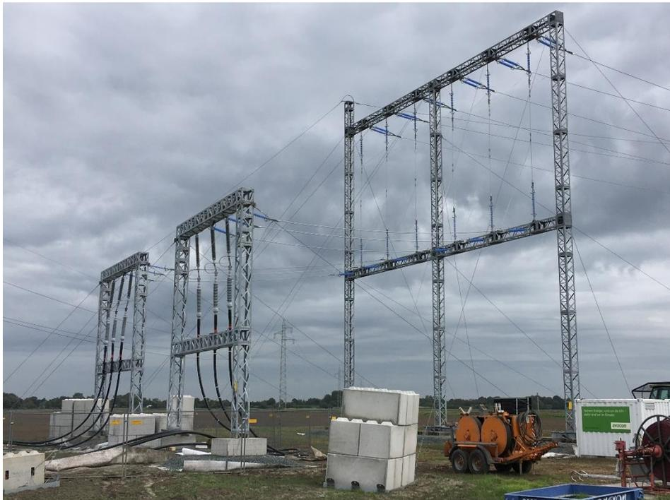
Abbildung 3 110-kV-Freileitungsprovisorium zum Abspannen für zwei Systeme
