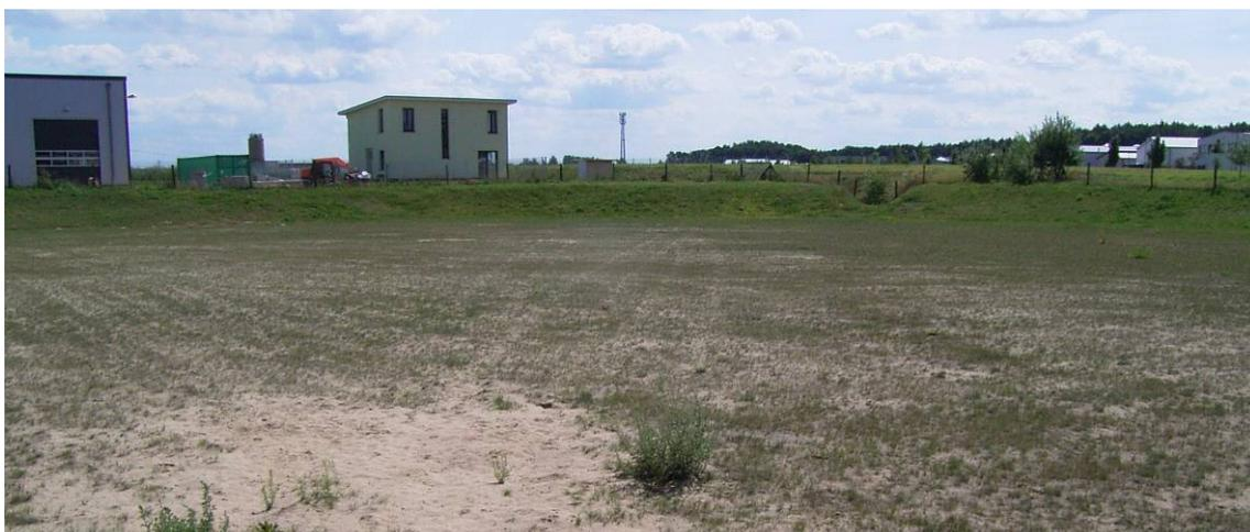
**Abbildung 7: Regenrückhaltebecken im Gewerbegebiet, trocken**
