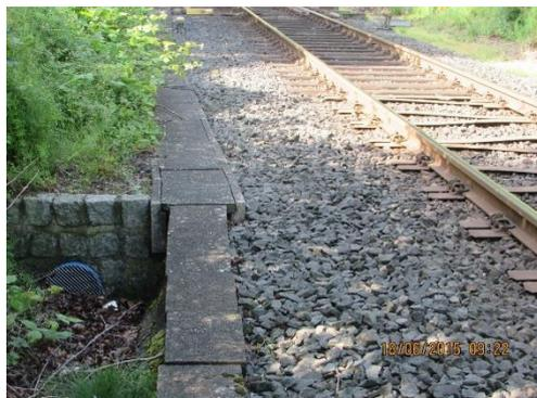
Bild 1: Einlaufbauwerk auf der Ostseite der AKN
