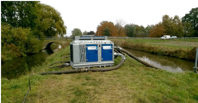
Abbildung 5: Überpumpen vom Rhin / Lesigfelder Wettern (links) ins Schwarzwasser (rechts)
