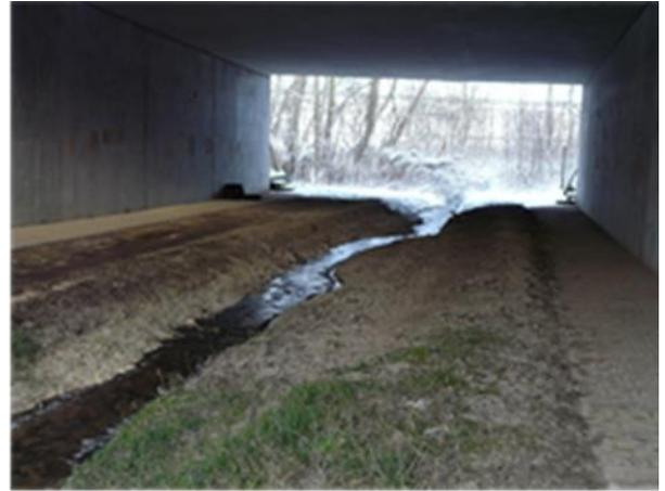
Abbildung 22: naturnahes Gewässerbett. Sicherung mit Wasserbausteinen.
