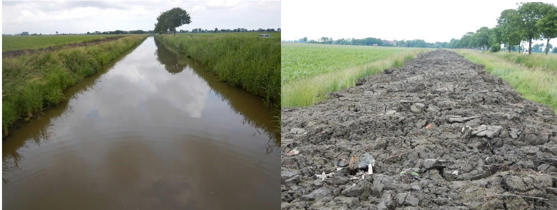
Abbildung 5: links: Schwarzwasser (1.4), rechts: Aushub nach Räumung Juni 2016
