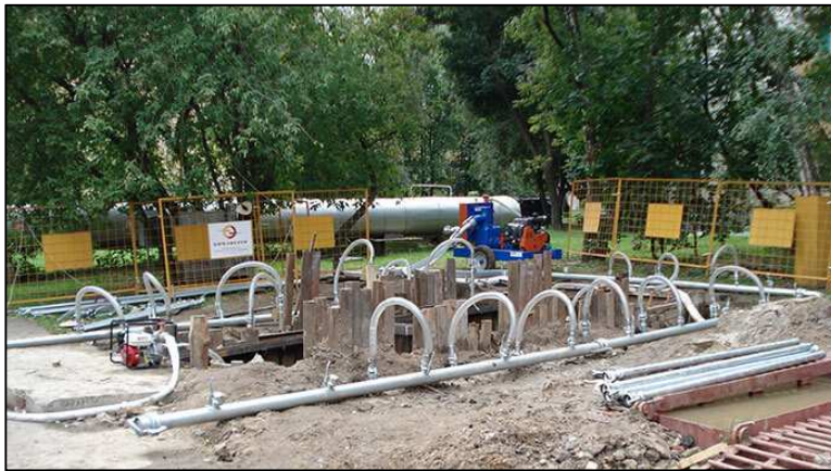
Abbildung 5: Praxisbeispiel für geschlossene Wasserhaltung mit Vakuumpumpen betrieben mit einem Dieselpumpenaggregat /3/
