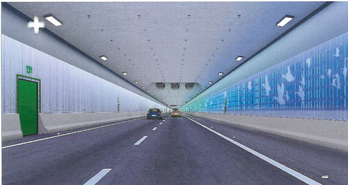
Abb. 5.2: Straßentunnel (Fahrbahnen Richtung Deutschland)
