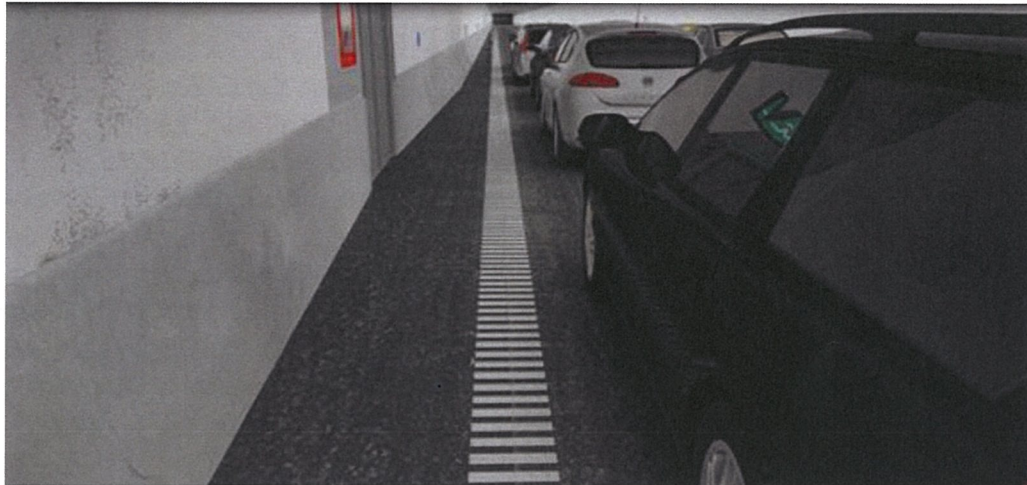
Abb. 5.5: Randstreifen an der Zentralgalerie
