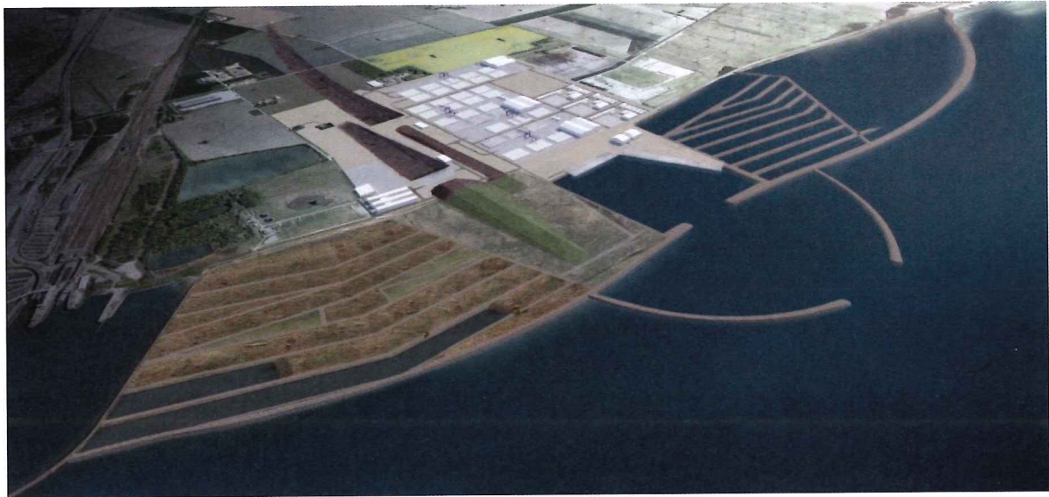
Abbildung 1-15 Bohrtunnelbaustelle auf Lolland
