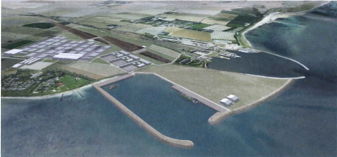
Abbildung 1-14 Bohrtunnelbaustelle auf Fehmarn
