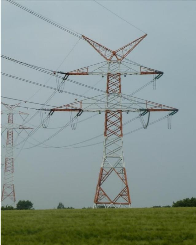
**Abbildung 1:** Abspann-/Winkelmast einer 380-kV-Leitung
