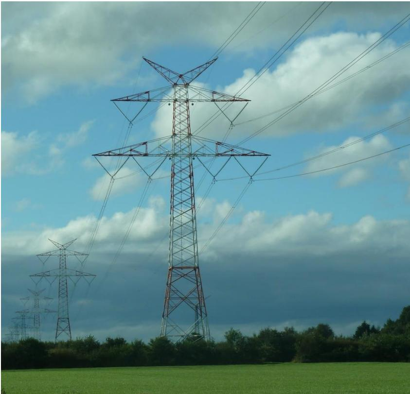
**Abbildung 2:** Tragmast einer 380-kV-Leitung
