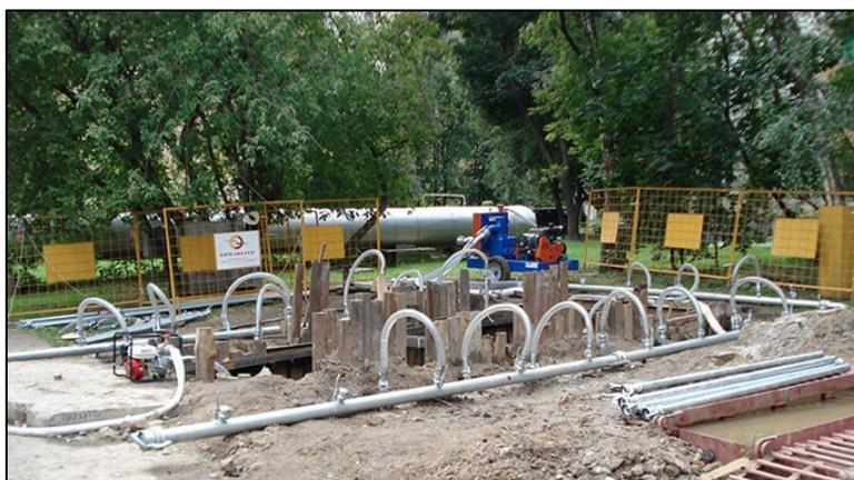
Abbildung 13: Praxisbeispiel für geschlossene Wasserhaltung mit Vakuum-Filterlanzen betrieben mit einem Dieselpumpaggregat /19/
