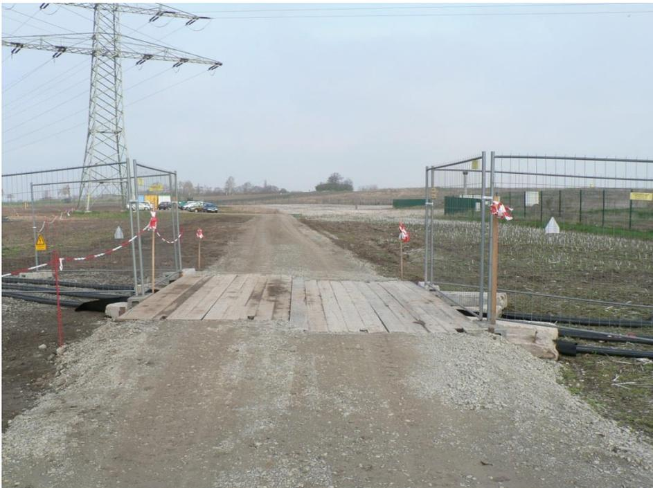
Abbildung 20: Beispiel eines Kabelprovisoriums über einen Weg
