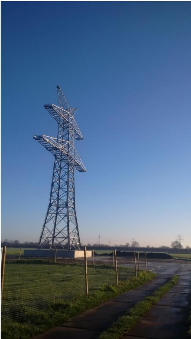
Abbildung 18: 380-kV-Freileitungsprovisorium für zwei Systeme (Auflastvariante Stahlgittermast)
