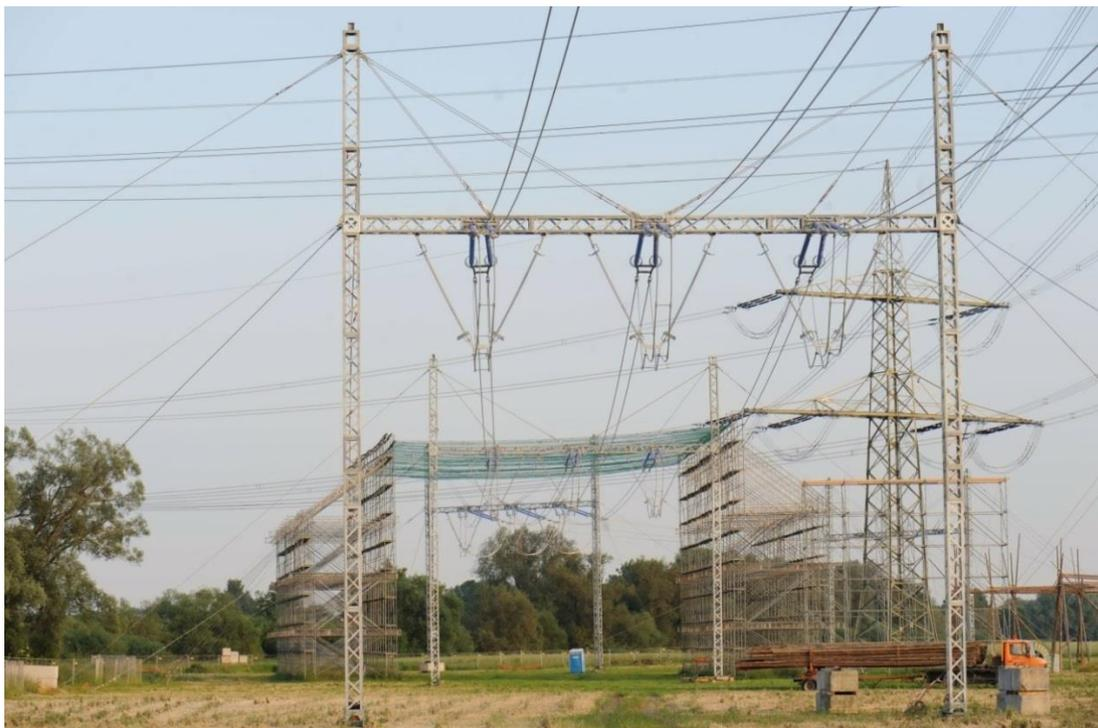
Abbildung 14: 380-kV-Freileitungsprovisorium für ein System, mit errichtetem Schutzgerüst (mit Abankerung)
