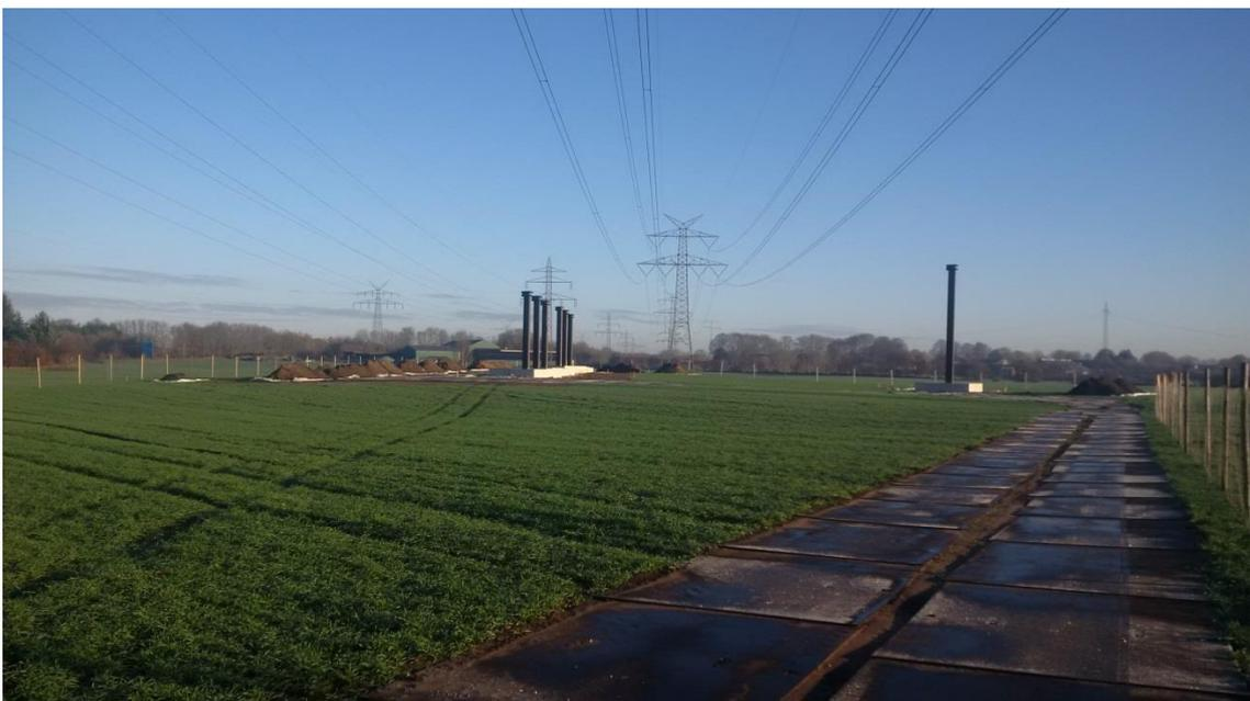
Abbildung 17: 380-kV-Freileitungsprovisorium (Stahlvollwand) für zwei Systeme (mit Auflast, ohne Traversen; Abspannung jeweils am Stahlvollwandprofil)
