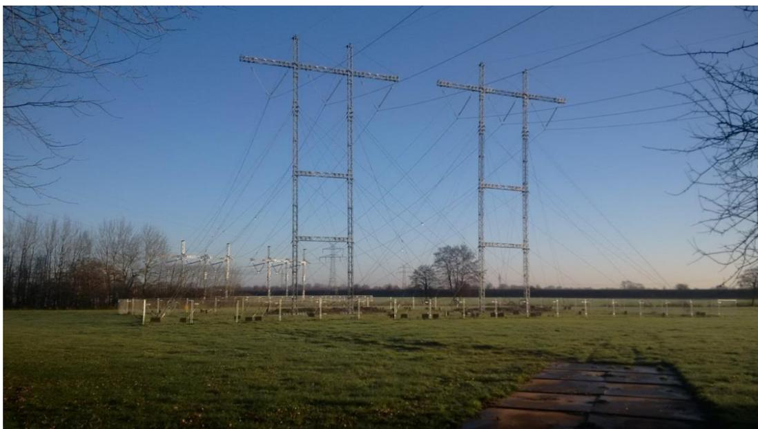
Abbildung 15: 380-kV-Freileitungsprovisorium für zwei Systeme (mit Abankerung)
