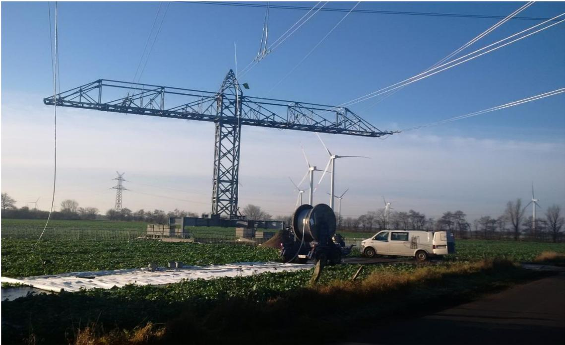
Abbildung 16: 380-kV-Freileitungsprovisorium (Gitterstahl) für zwei Systeme (mit Auflast)
