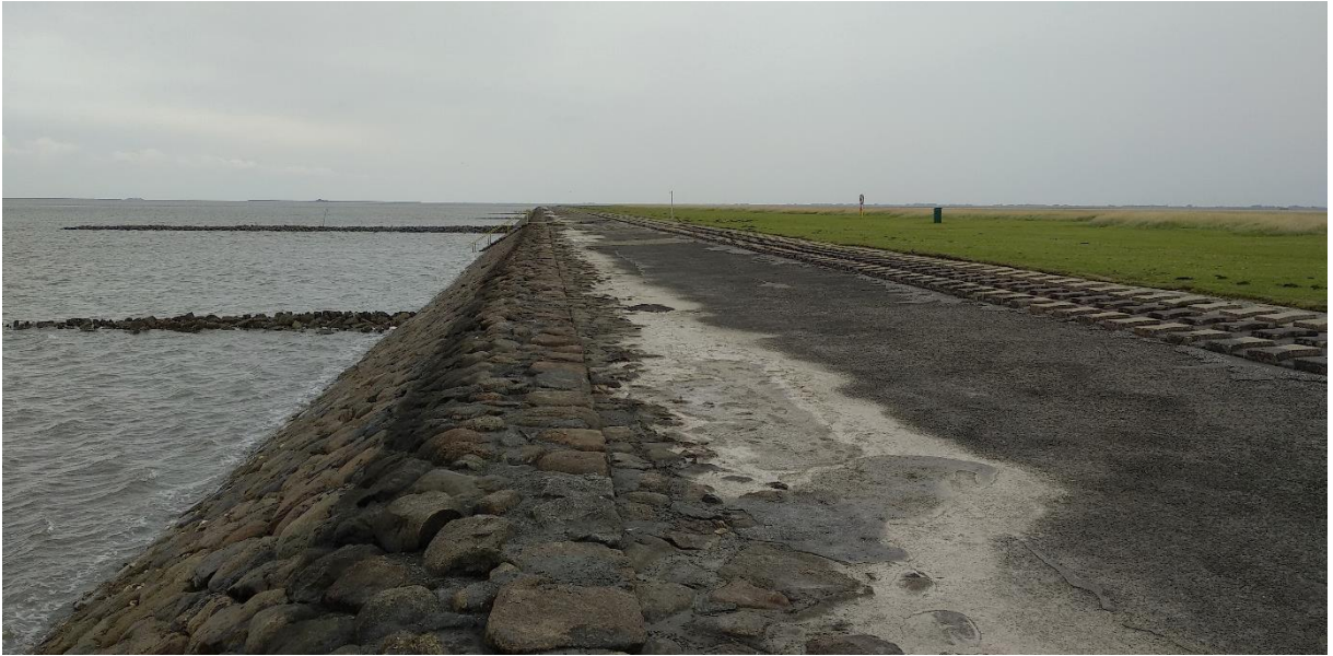
Abbildung 22: Deckwerk an der Anlandungsstelle auf der Hamburger Hallig.
