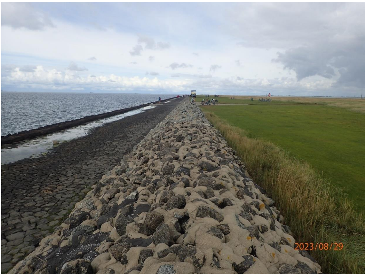
Abbildung 5: Deckwerk der Halligkante.
