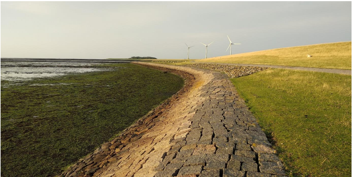
Abbildung 23: Deckwerk an der Anlandungsstelle Pellworm; rechts der Landesschutzdeich; links Vorländer; im Hintergrund die Vogelkoje.
