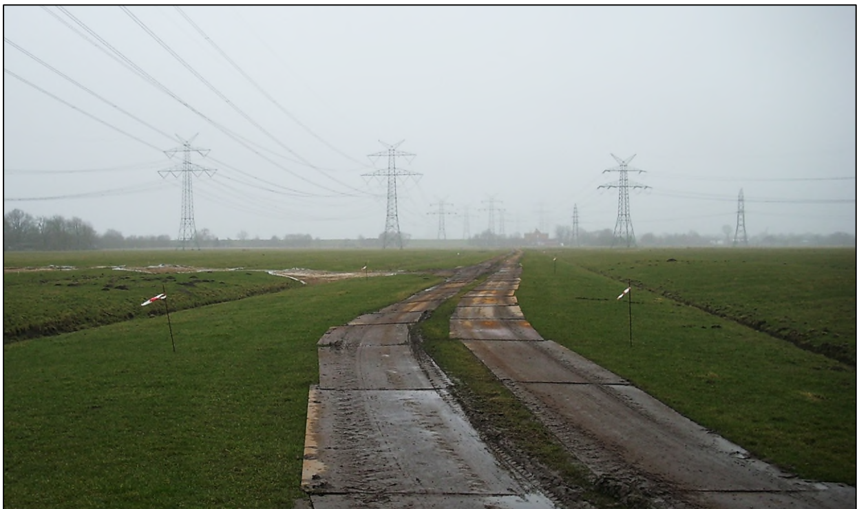
Abb. 3: Beispiel für Bodenschutzmaßnahmen ( "Baggermatten" )
