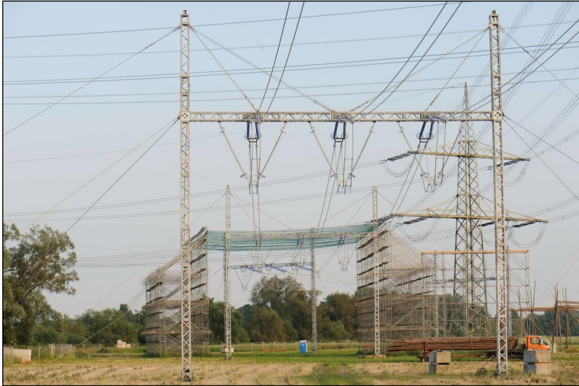
Abbildung 17: 380-kV-Freileitungsprovisorium für ein System, mit errichtetem Schutzgerüst
