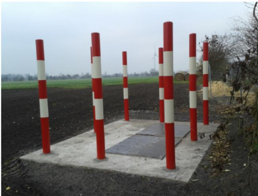
Abbildung 12: Cross-Bonding-Standort mit Sicherheitsabspernung (hier mit zwei Schächten)
