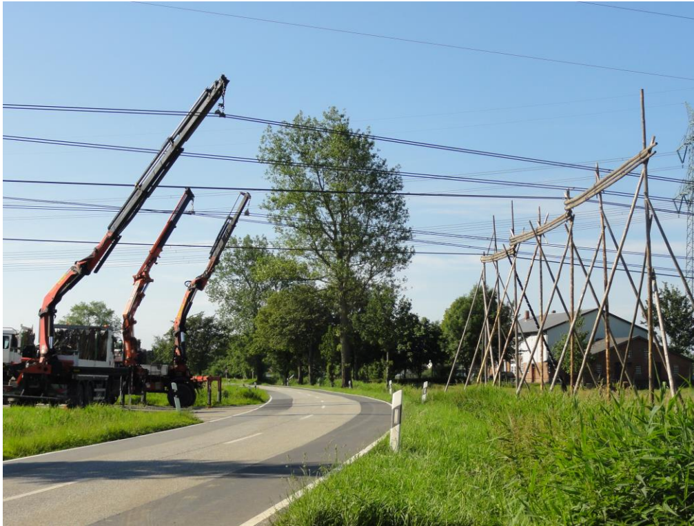
Abbildung 16: Schutzgerüst in Leichtbauweise
