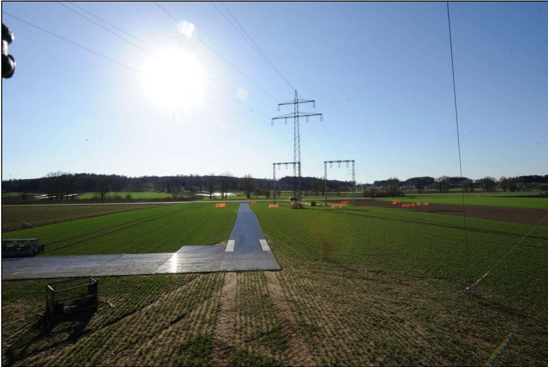
Abbildung 14: Baustraße als Plattenzufahrt bei einer Freileitungsbaustelle
